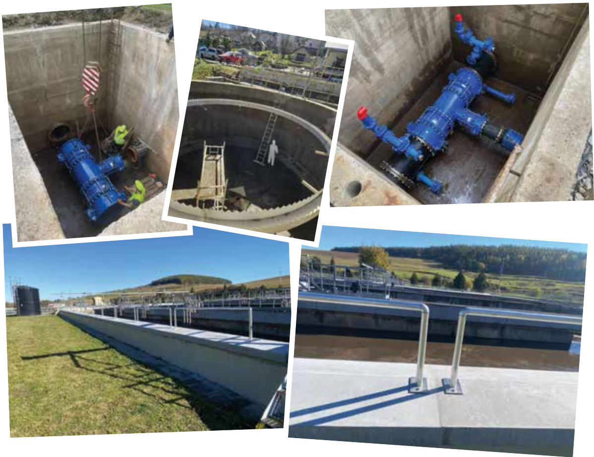
Redukčné šachty PVS (návrh / realizácia)
